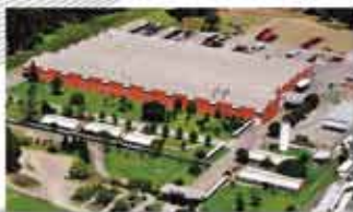
Unidade montadora de veículos. Casa do Sul - RS - Brasil
